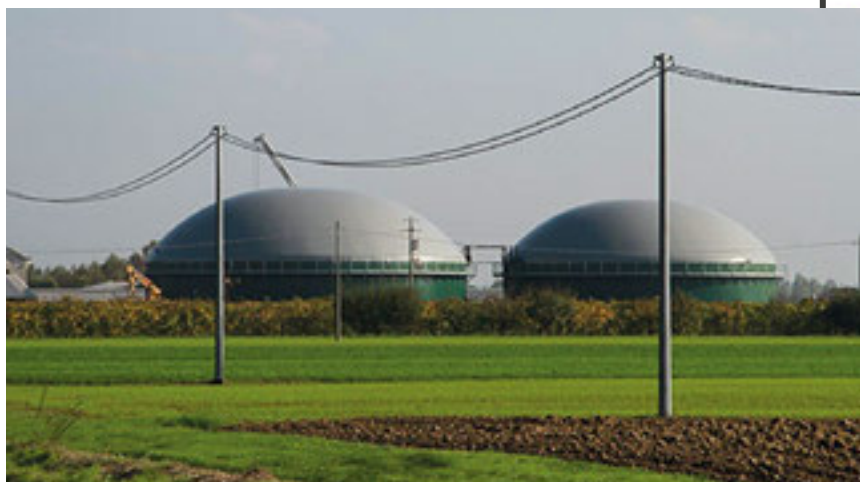
Die Kraft-Wärme-Anlage in San Rocco (Nähe Bologna) macht aus Mist Strom und Wärme.
